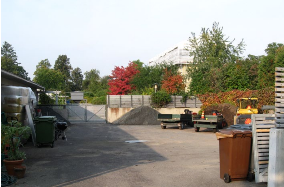
Kaisaniemen peruskorjauksessa 2012–2013 hävinneitä näkymiä. Tätä huoltopihaa pienennettiin, ja uusi huoltoalue rakennettiin Kaisaniemenrannan rantaportin läheisyyteen. Takaoikealla korjataan Ikkalan kattoa. Kuva 25.9.2010, Paula Havas-Matilainen.
